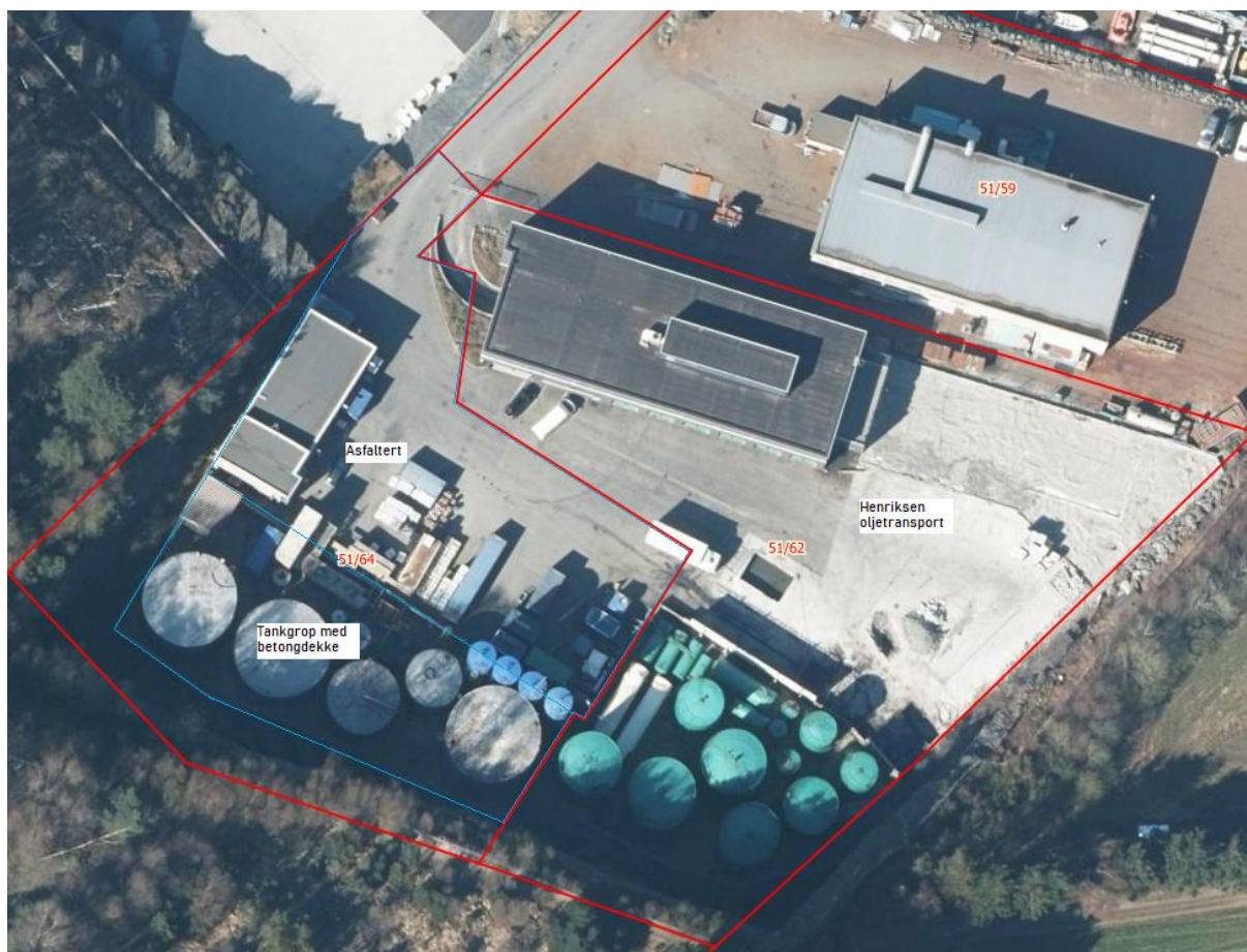
Figur 3. Anlegget som NW disponerer i dag. Tankgropen er rundt 1150 m 2 og har betongdekke. 150 m 2 er gruset overvannsoppsamling mellom fjellvegg og tankgrop og 2360 m 2 er asfaltert med fall til oppsamlingskummer koblet til oljeutskiller.
