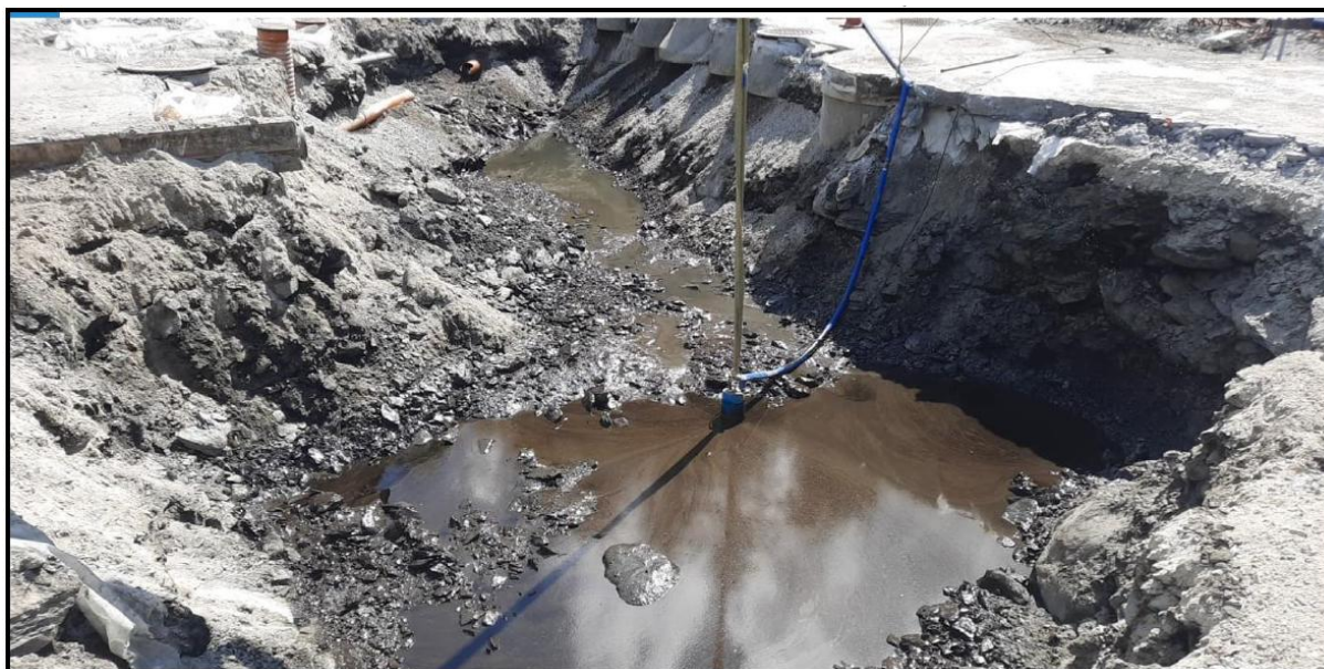
Figur 10. Foto av utgravd område med etablert pumpe for senkning av vannstand, fra opprydning etter brann. Bildet er hentet fra sluttrapport etter opprydning 2022 (GEO247, 2022).
